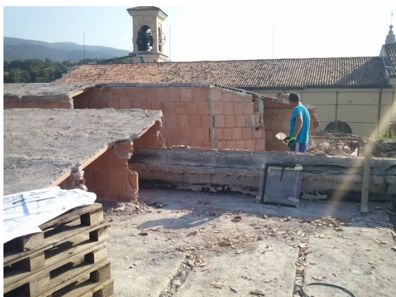
Fase lavorativa di rimozione dei muricci e tavelloni.
