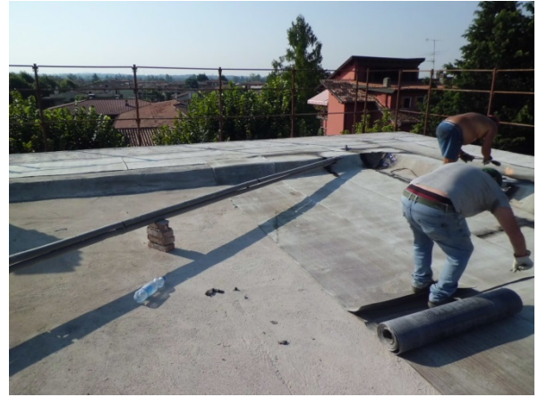
Sopra e a lato fasi lavorative della posa della guaina impermeabile
