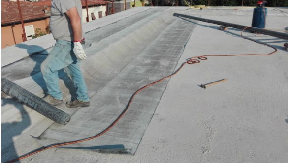
Sopra e a lato fasi lavorative della posa della guaina impermeabile
